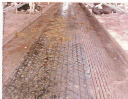
通路に下痢便と正常便が混在
