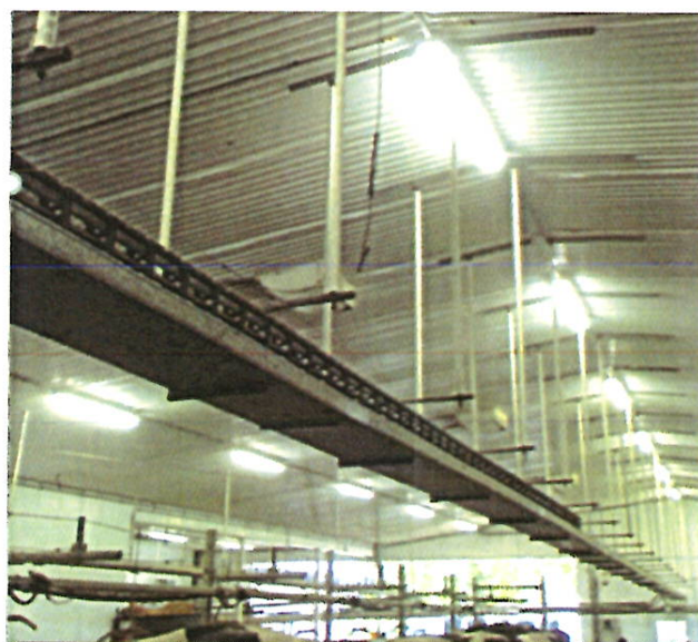
上のトレイにロボレオに必要な電源やミルクの配管が載せてある。
