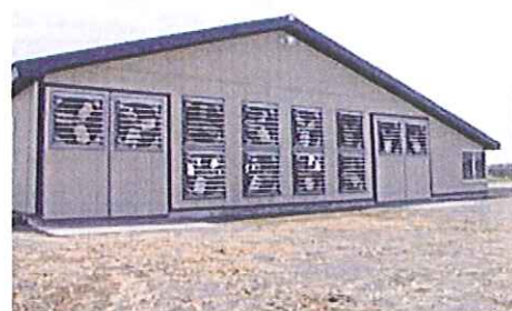
一般的な指標の倍のファンをつけた タイストール牛舎(上) 高温多湿の日でも牛はよく寝ている(下)
