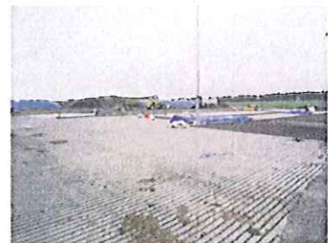
建設中の新牛舎
