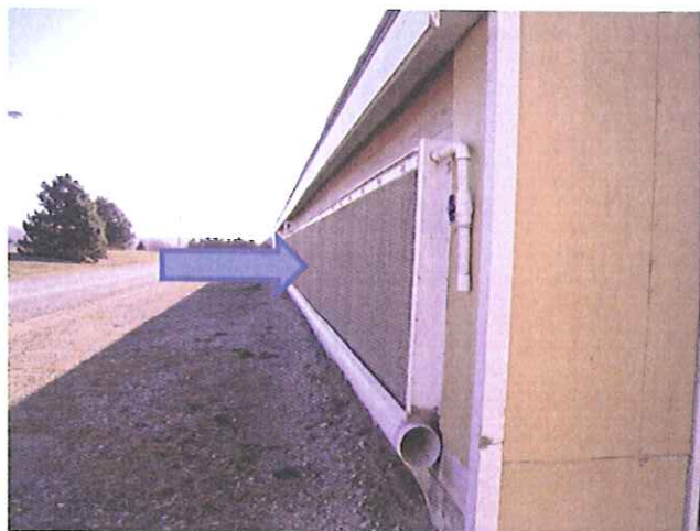
エバポレーションパッド（蒸散パッド）：上部からパッドへ水が浸み込んで、そこを通る空気が冷される
