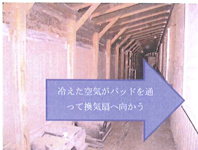
パッド（左壁側の内側は密閉され、パッドを通った空気しか入らないようになっている。右壁に換気扇がついていて、この冷えた空気を乾乳ペンに吹き出す
