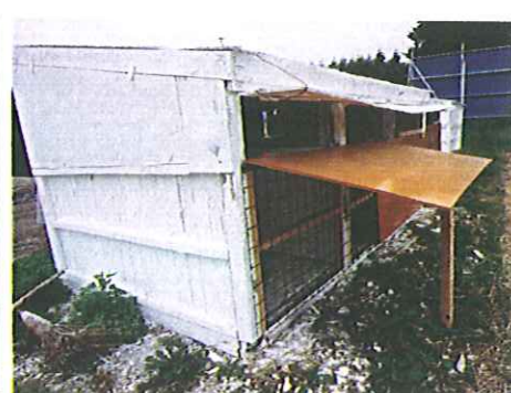
ハッチの奥の壁をメッシュに変更。壁は開閉可能なように改造。
