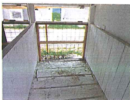
ハッチの奥の壁をメッシュに変更。壁は開閉可能なように改造。
