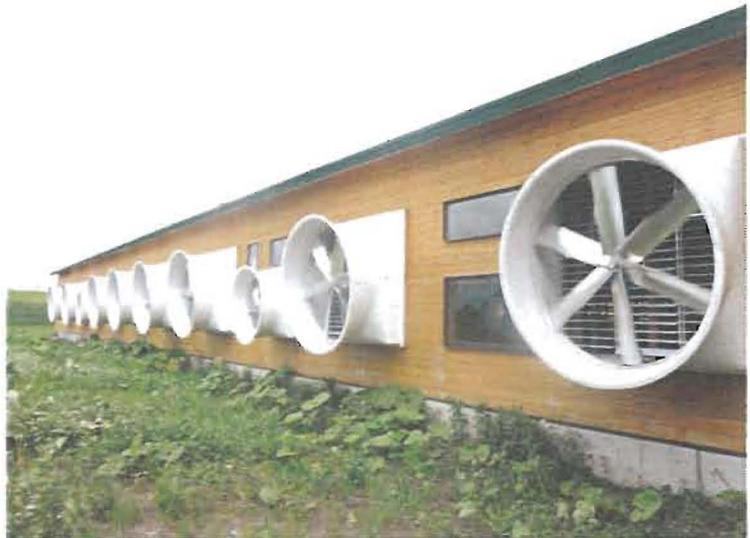
100頭フリーストール牛舎。直径180cmのファン8台と直径120cmのインバーター付ファン2台を牛舎側面に設置。最大15秒で牛舎内の空気を回転させることができる。
