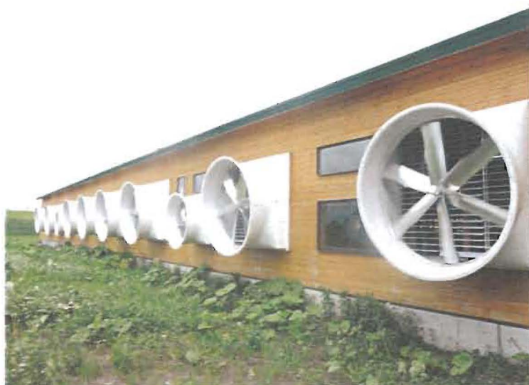
100頭フリーストール牛舎。直径180cmのファン8台と直径120cmのインバーター付ファン2台を牛舎側面に設置。最大15秒で牛舎内の空気を回転させることができる。
