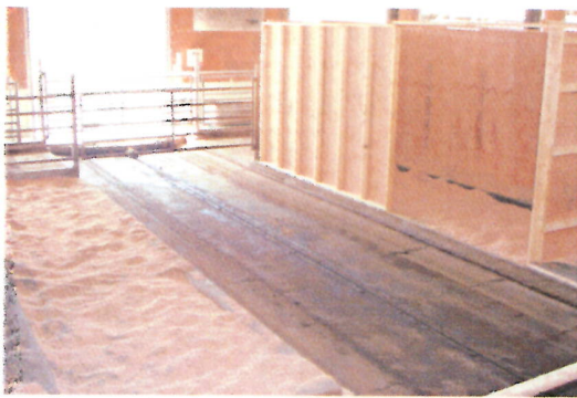
写真2 仮のシェルター
