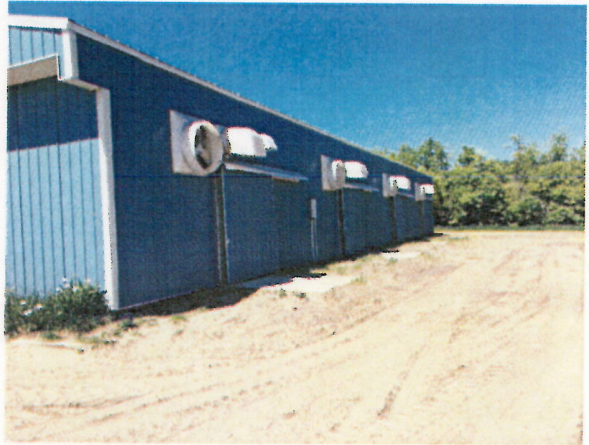
【哺育舎の換気扇…外観】
