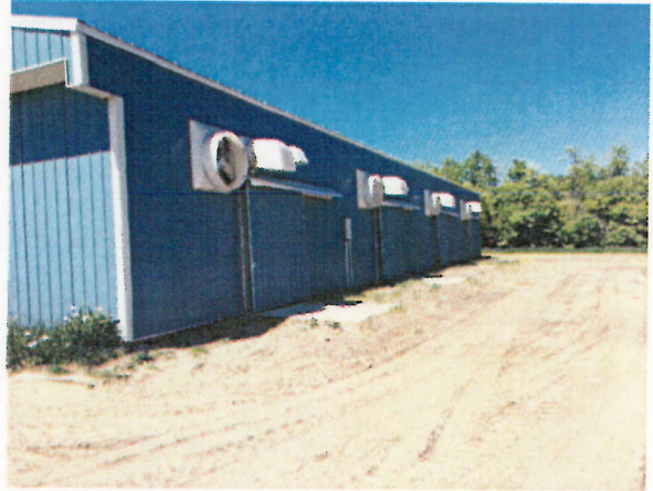
【哺育舎の換気扇…外観】
