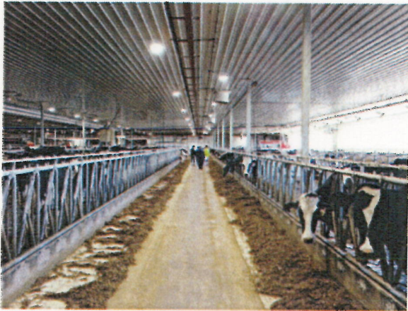
【内部…ロボットで給餌するので狭い飼槽通路】
