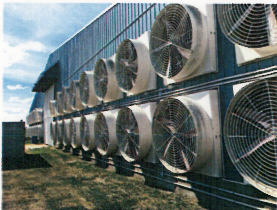
【800 頭牛舎の換気扇②…トンネル換気】
